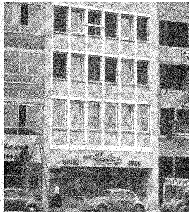
Facadeudsnit fra tysk forsøgsbyggeri i Ulm. Vinduerne er udført som „Dreh-Kipp-Fenster“. Næstøreste vinduesrække til højre og -venstre er åbne i ventilationsstilling, de øvrige åbne vinduer er i pudsestilling.
